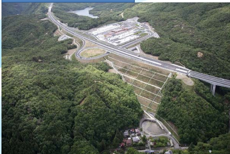
宝塚北SAと高盛土の航空写真
