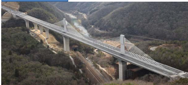
生野大橋の航空写真
