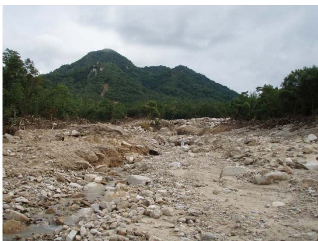
写真-1 被災直後の状況 (H21.7 撮影)
