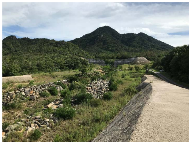
写真-2 現在の状況 (R1.9 撮影)
