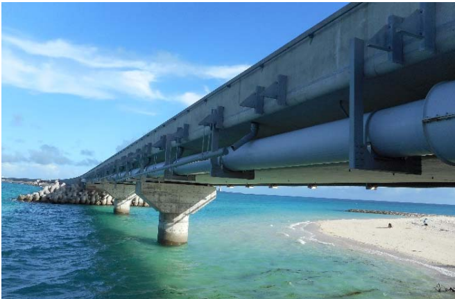
伊良部大橋 (3540m) に送水管を添架
